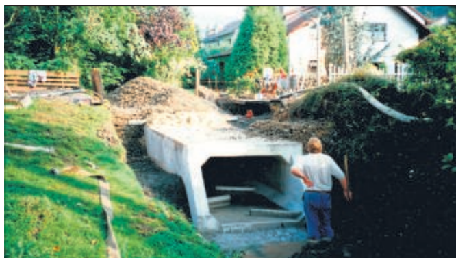
20 Jahre vorher - 1999 wurde für den Hochwasserschutz im Dorf gebaut
