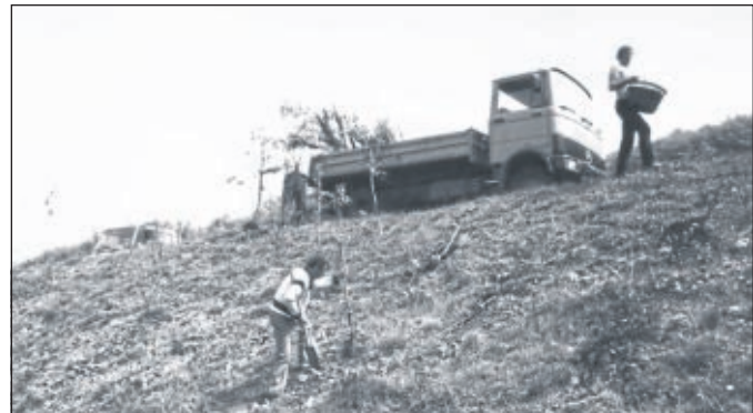
Am neuen Sportplatz Elmshagen wird die Böschung bepflanz
