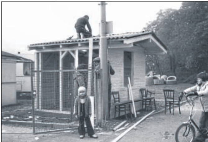
Am Sportplatz Hoof wird ein neues Kassenhäuschen errichtet
