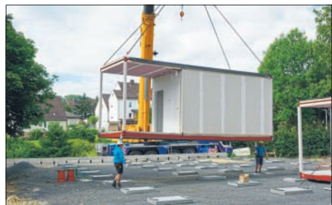
2020: Rohbau fertig in drei Tagen - die Kita Baunaknirpse in Hoof wurde aus Modulen gebaut
