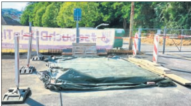
Der Beton ist nun auch da.
