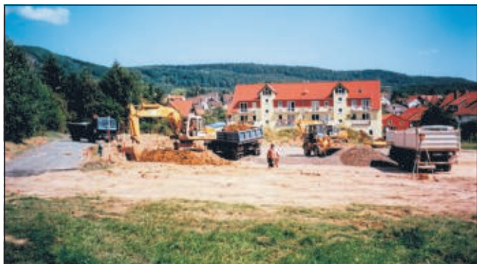
Baubeginn - Foto im August 1999
