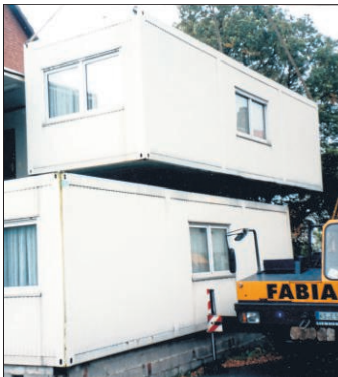
Die Bürocontainer neben dem Rathaus werden im September 2002 abgebaut
