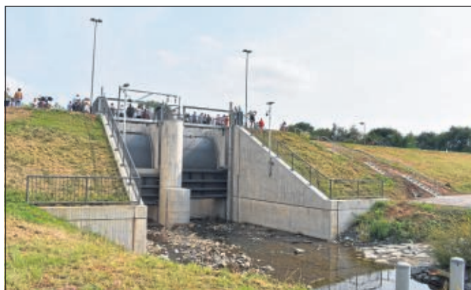
Das Hochwasserrückhaltebecken in Kirchbauna ist nach dem Polder Schefferfeld (Fassungsvermögen 230.000 Kubikmeter) das zweitgrößte im System (100.000 Kubikmeter Fassungsvermögen)
