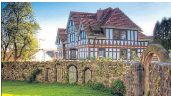
2008: Gemeindehaus und Kirchhofmauer in Elgershausen wurden saniert
