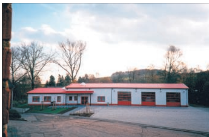
1998: Das neue Feuerwehrhaus im Ortsteil Hoof
