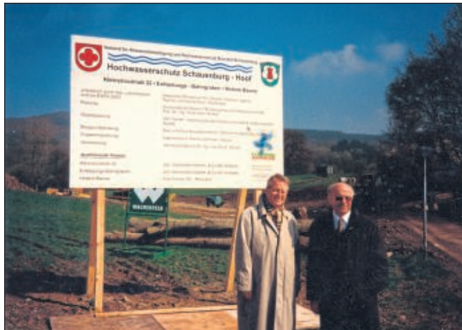
1999: Baubeginn für das Kleinstrückhaltebecken Katzenmühle in Hoof, im Bild die Bürgermeister Schauenburgs und Baunatals, Willi Klein und Heinz Grenacher
